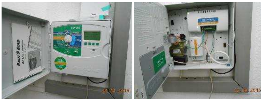
Programador Rain Bird ESP-LXD amb mòdem per a connexió a la plataforma IQ
