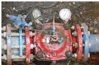
Arqueta amb: filtre i vàlvula amb pilot reductor de pressió
