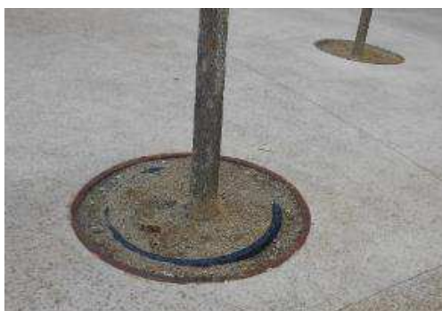
Anell de degoteig de 7 degotadors al voltant de l'arbre
