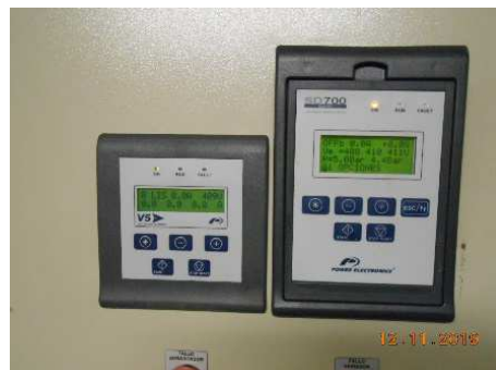
Quadre bombes Detall pantalles variadors de freqüència
