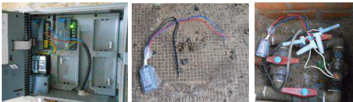
Programador per a descodificadors i descodificador instal·lat en arqueta
