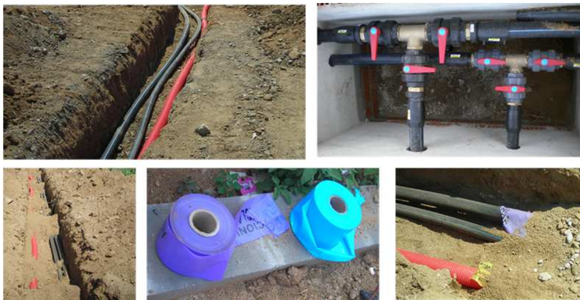
Canonades primàries de reg i de boques de reg
