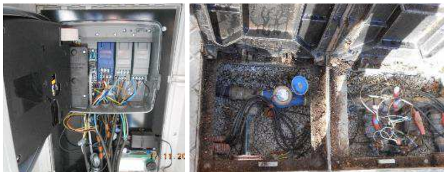
Programador modular amb mòdul de connexió de cabalímetre
