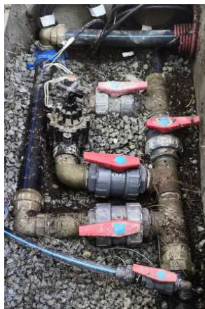
Arquetes amb bypass mestre per a la xarxa de reg, la derivació a les boques de reg, amb vàlvula d'esfera, és sempre prèvia al bypass mestre.
