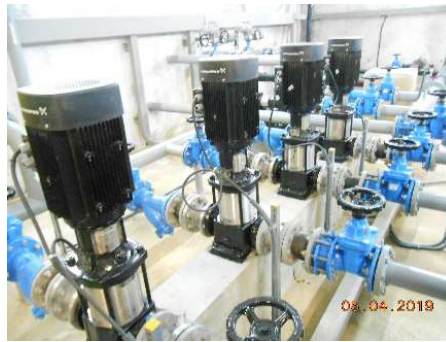
Bomba centrífuga vertical Grups de bombes en paral·lel
