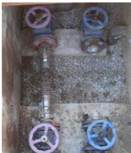
Senyalització de reg amb aigua no potable. Aixetes de diferent color per freàtica i potable
