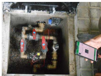
Programació amb consola via infraroig. Programació amb mòbil via Bluetooth (BT)
