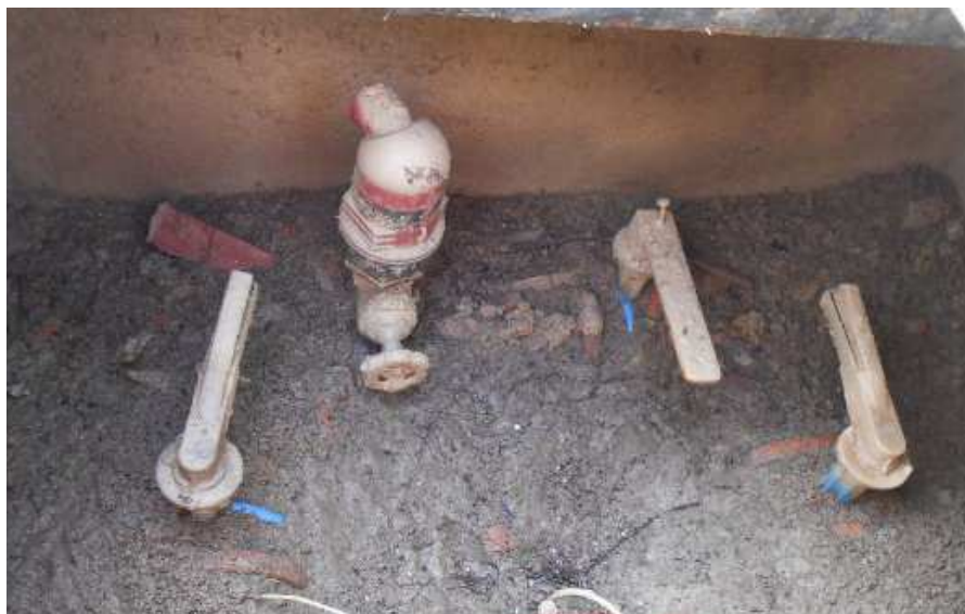
Vàlvula de ventosa sobre vàlvula de comporta, permet la sortida i entrada d'aire a la canonada.
