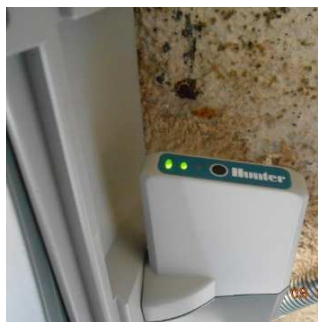
Programador amb mòdul de comunicació, "router" amb SIM i connexió al mòdul amb cable "Ethernet"
