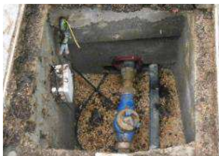
Diferents models de sondes de cabal i comptadors amb emissors de polsos utilitzats com a cabalímetres pels programadors
