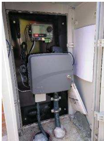
Programador elèctric TORO TMC 424 amb mòdem per a 'plataforma Tricomm2
