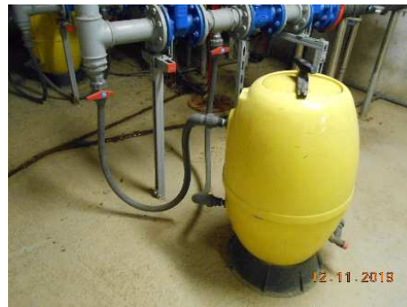
Sala tècnica amb dosificador Dosificador d'adob tipus tanc de fertilitzant
