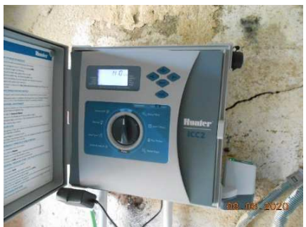
Programador amb mòdul de comunicació, "router" amb SIM i connexió al mòdul amb cable "Ethernet"
